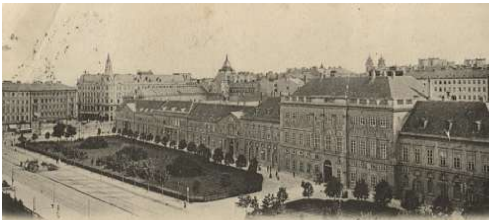
K. u. k. Hof- und Kgl. Stalls, Hofstallstrasse 1.
