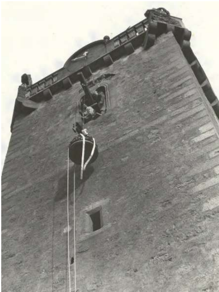
Vytažení zvonu na věž kostela
