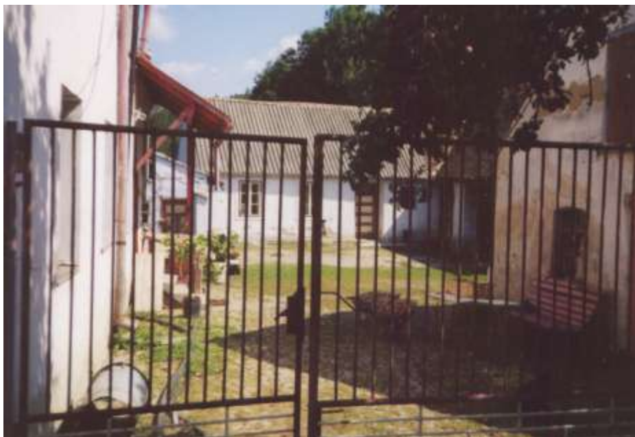
Pozůstalé stavení z bývalého Spáleného mlýna
