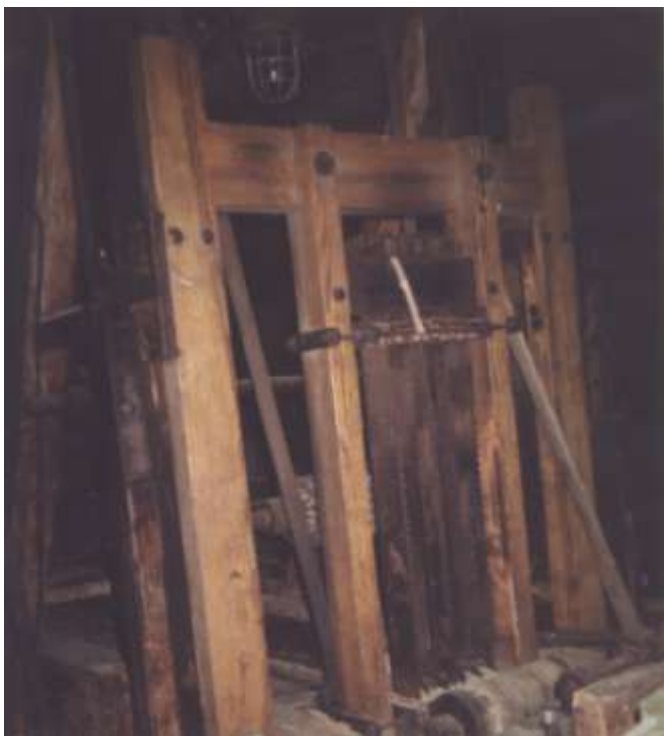
Stejskalův mlýn – pila
