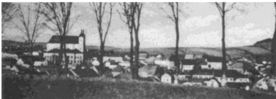
celkový pohled / tabáková továrna / nábřeží Budišovky
