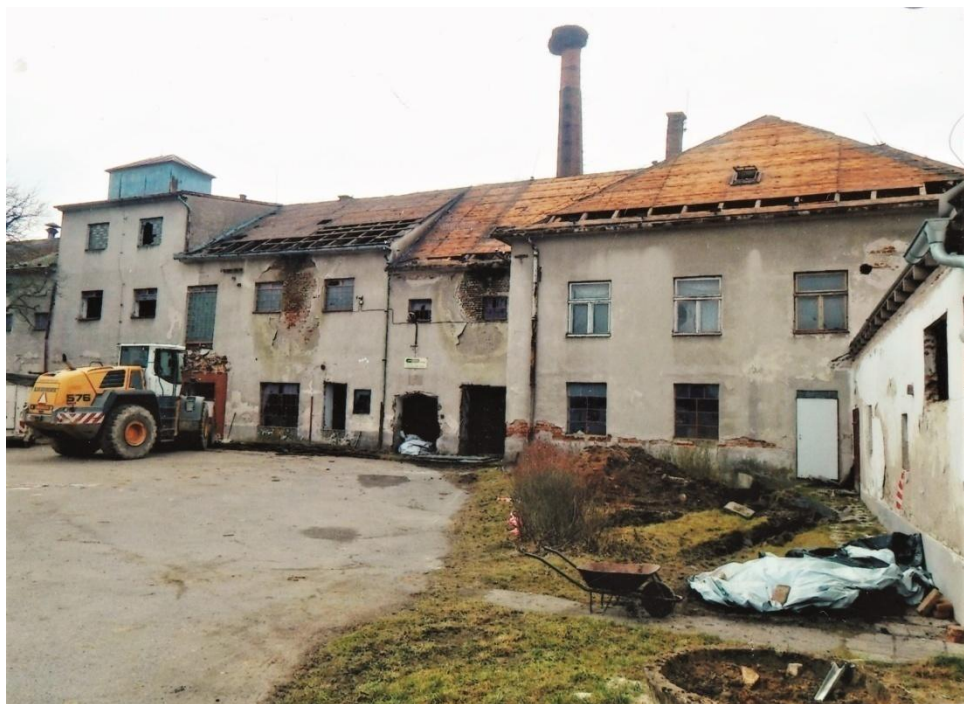
Lihovar v Okarci před demolicí
