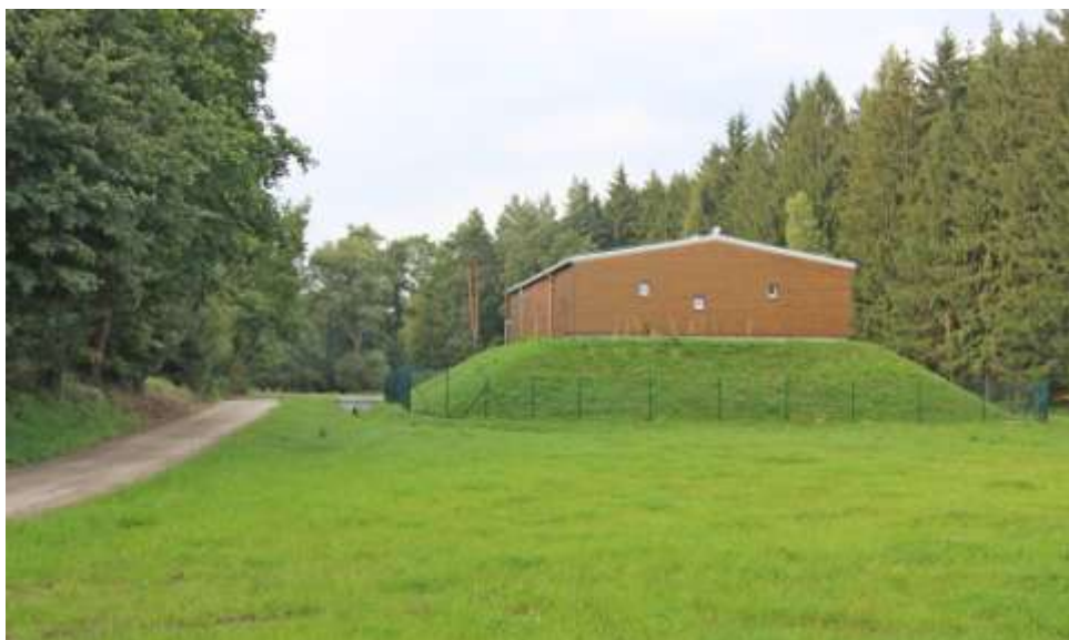
44. Čistírna odpadních vod
