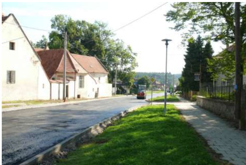
Obrubníky u obnovované vozovky pod žel. přejezdem
