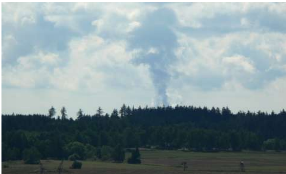
Nad lesem pára z chladicích věží dukovanské elektrárny
