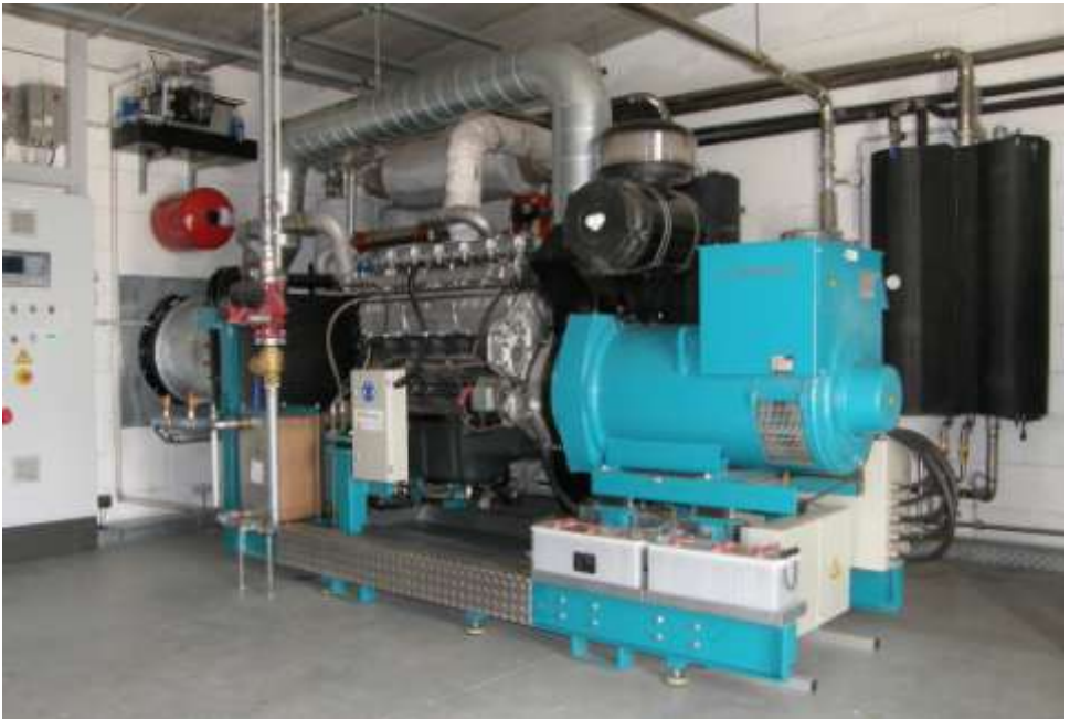
Kogenerační jednotka – jeden z jejich motorů s generátorem
