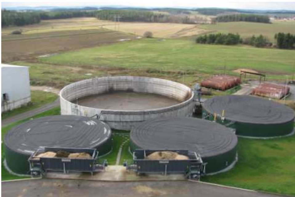
Zleva: dva fermentory, dofermentor, za nimi výstupní jímka
