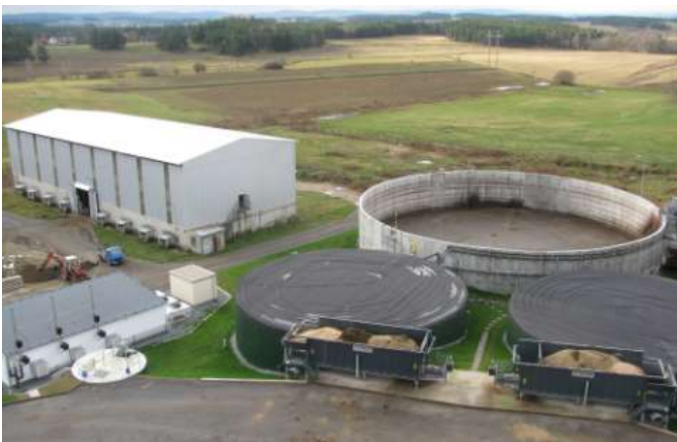
Zleva: strojovna, vedle ní ventilátory a trafostanice; za strojovnou vstupní jímka, dva fermentory se zásobníky, za nimi výstupní jímka
