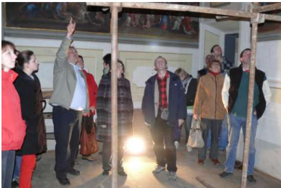
To je ten strop, který spadne, když nic neuděláme
