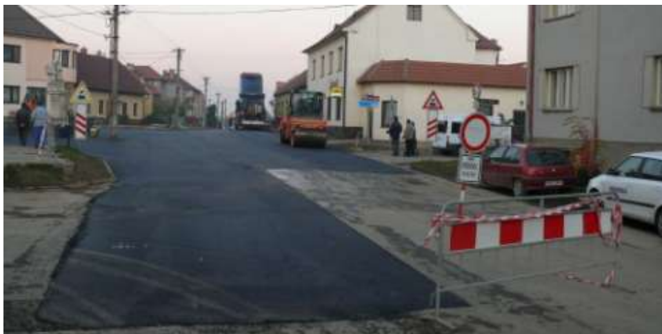
Úpravy povrchu patří ke stavbě, konečná úprava silnic a místních komunikací proběhne po skončení stavby
