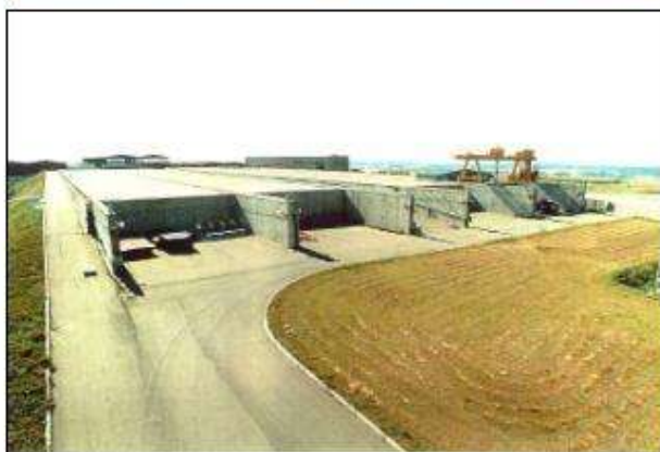
Foto 8: Úložiště RAO Dukovany – základací jámky
