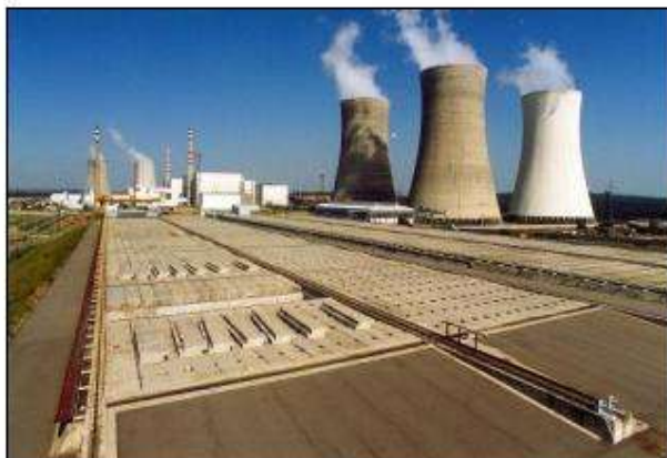
Foto 7: Úložiště RAO v areálu jaderné elektrárny Dukovany
