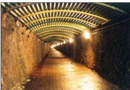
Foto 5: Úlož Bratrství, (detail – chodba pro obsluhu a manipulaci s RAO)
