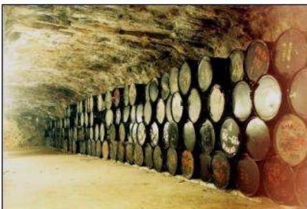
Foto 6: Úlož Bratrství, (detail – úložné prostory se sudy s RAO)
