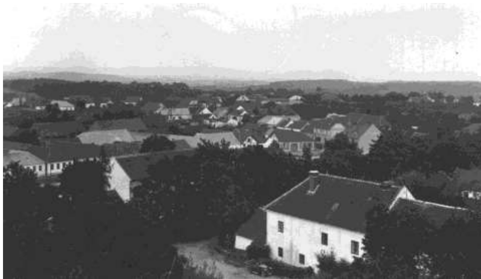
pohled z věže na severovýchod (30. léta)
