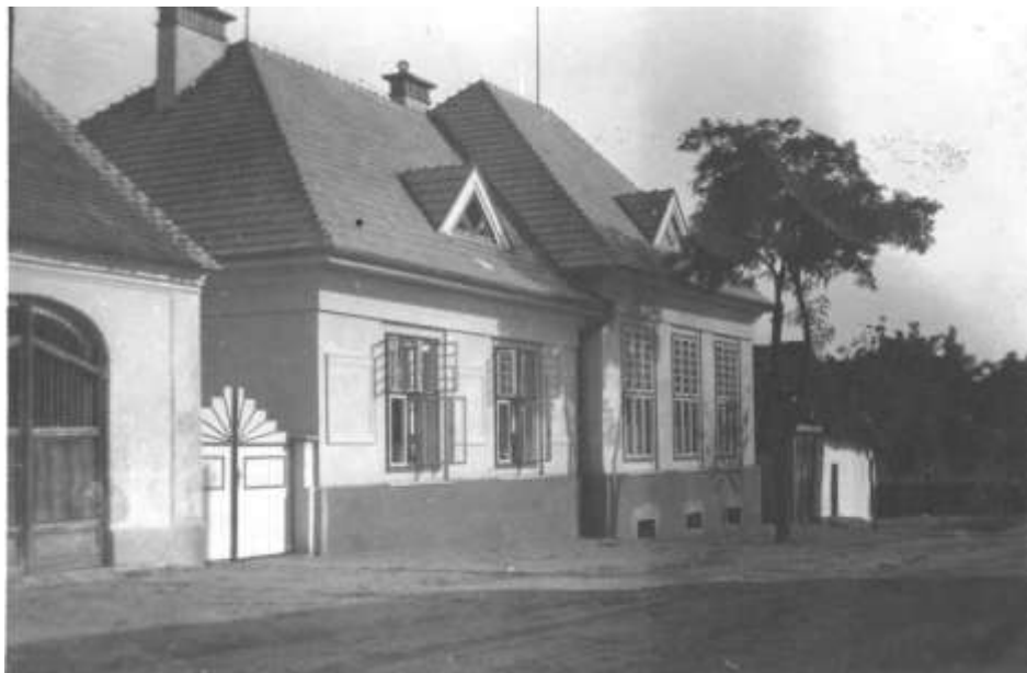
Bývalá hasičská zbrojnice, nalevo od vrátek
