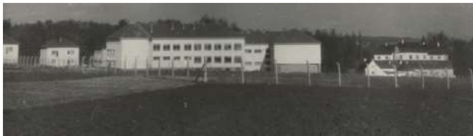
Stavba nové školy
