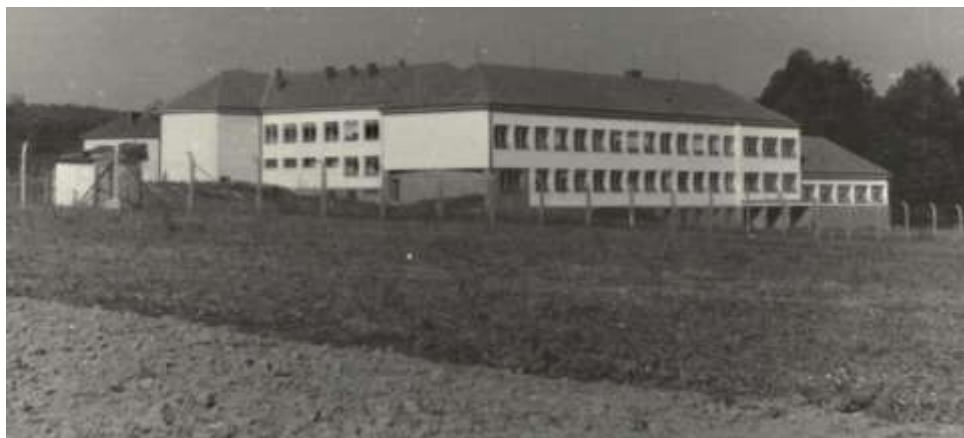
Stavba nové školy
